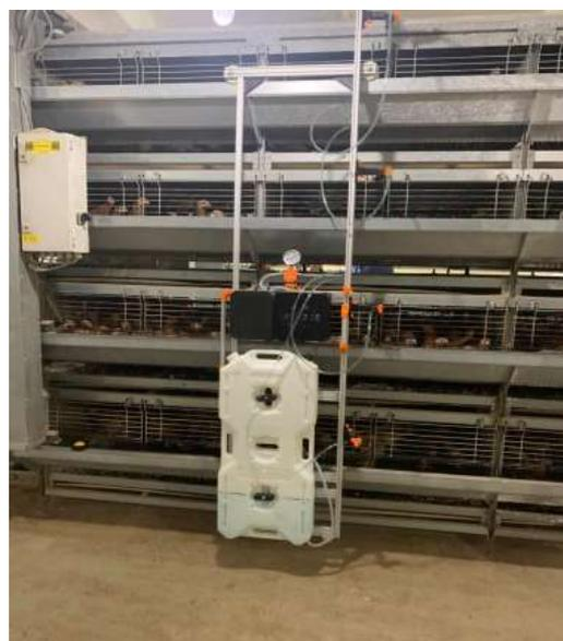
Рис. 4. Спрей-рамки марки «Symbio Iteris» в закреплённом состоянии на клеточной батарее
